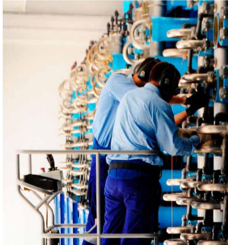
las membranas de ósmosis. Hay un bastidor más para la recuperación; tanto del agua de rechazo como por la presión, así se consigue aumentar la rentabilidad del proceso. Cada uno de estos racks cuenta con 343 membranas en su interior que pueden producir hasta 7000 m<sup>3</sup> de agua tratada diariamente.
